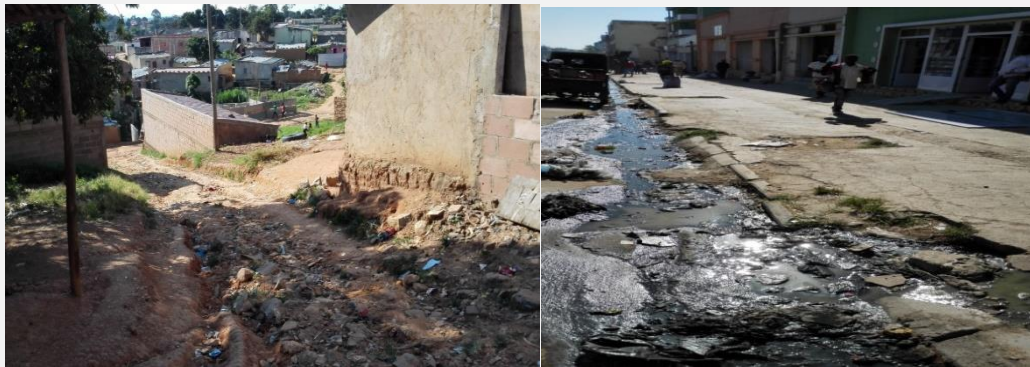
Fig.1: O Crescimento urbano, a força da correnteza das águas pluviais e a falta de drenagem ajudam as águas pluviais, domésticas ou industriais a ravinar a estrada de há um ano.
